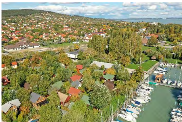
A fejlesztési terület nyugati szomszédja a Túravorlás Sportklub alsóörsi telepének telke a szabadon álló apartmanházakkal (fénykép: BORD Építész Stúdió)
