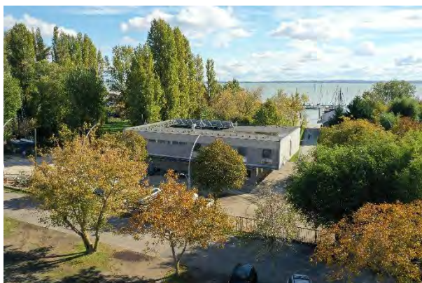
A volt vízisporttelep bejárata, háttérben a főépülettel, előtérben a Vasút utca aszfaltozott burkolatával (fénykép: BORD Építész Stúdió)
