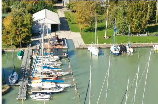
A sólyához egyenes, szilárd burkolatú út vezet a hajók minél egyszerűbb vízre eresztése érdekében. A csarnoképület közvetlenül a part mellett, a telekhatárra épült fel (fénykép: BORD Építész Stúdió)
