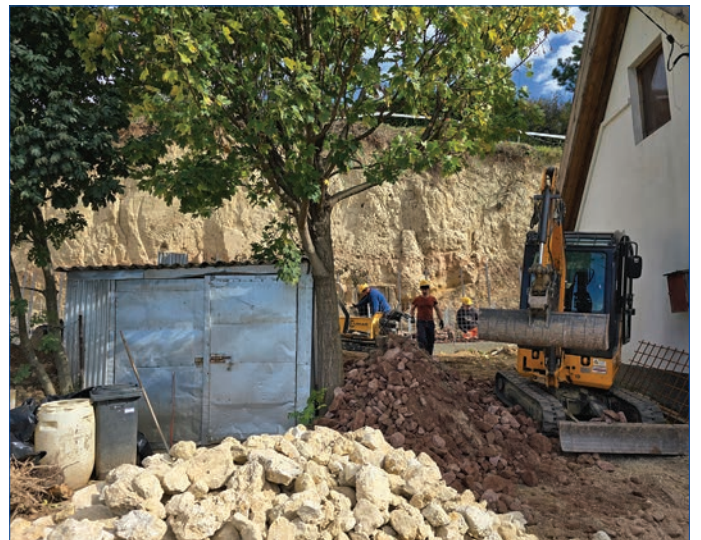
A korábbi vis maior pályázat segítségével november közepére elkészül a temető lépcső alatti löszfal elé épített támfal.
